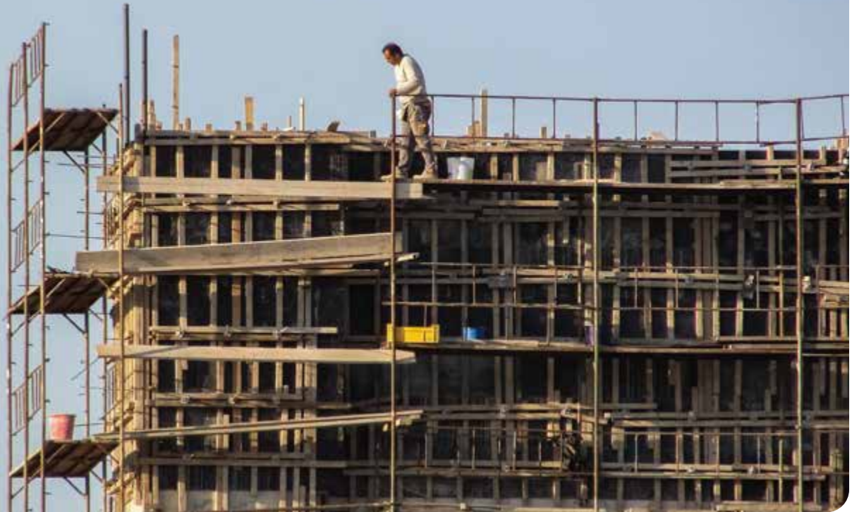
Paisatge habitual d'un edifici en construcció
